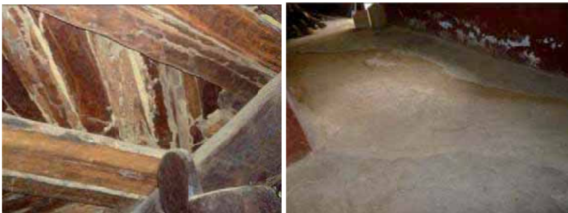
Attaque du bois (de téli) du plafond par les termites Dégradation du plancher. Ismaïlou Baldé, 2012
